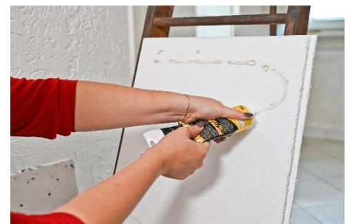
Abbildung 6: Aufbringen des Montageklebers.
